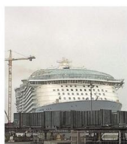
Le port de Saint-Nazaire et ses paquebots en construction, un lieu de souvenirs pour Christian Rousseau.
